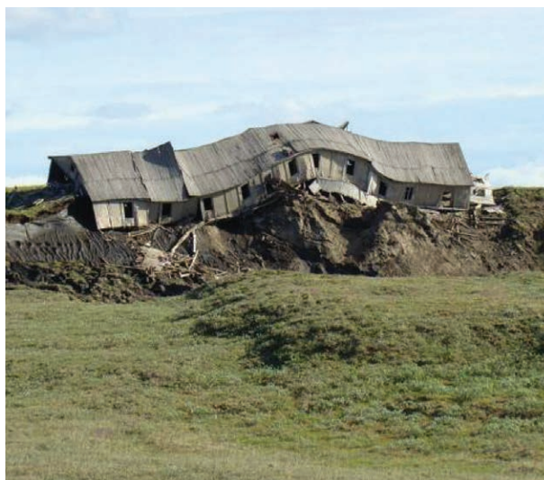
2.8.9-rasm. Bo'rtish yoki cho'kish tufayli yuzaga kelgan notekislikdan buzilgan harbiy qism binosi
