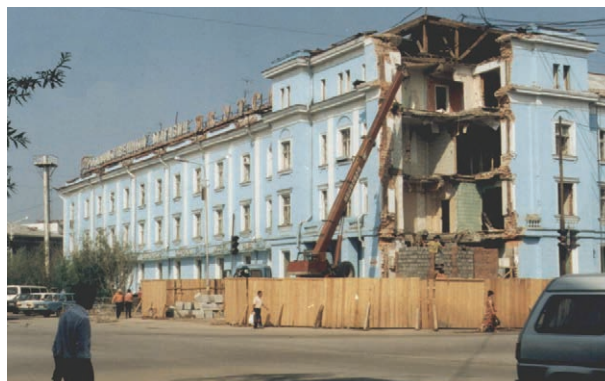
2.8.11-rasm. Burchak qismi buzilgan bino. Yakutsk shahrining markazi (Rossiya).
