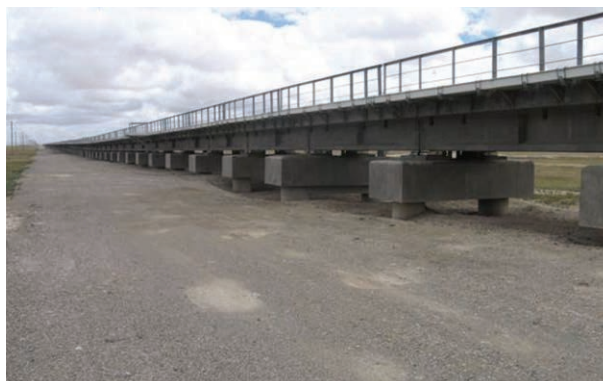
2.8.14-rasm. Yerga chuqur koʻmilgan maxsus tayanchlardagi yoʻl.
