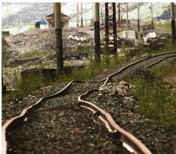
2.8.8-rasm. Temir yo'lining buzilgan qismi
